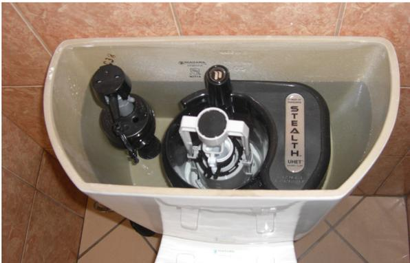
**Fotografía No 1:** Tanque del servicio sanitario de bajo consumo de 3 litros por descarga
