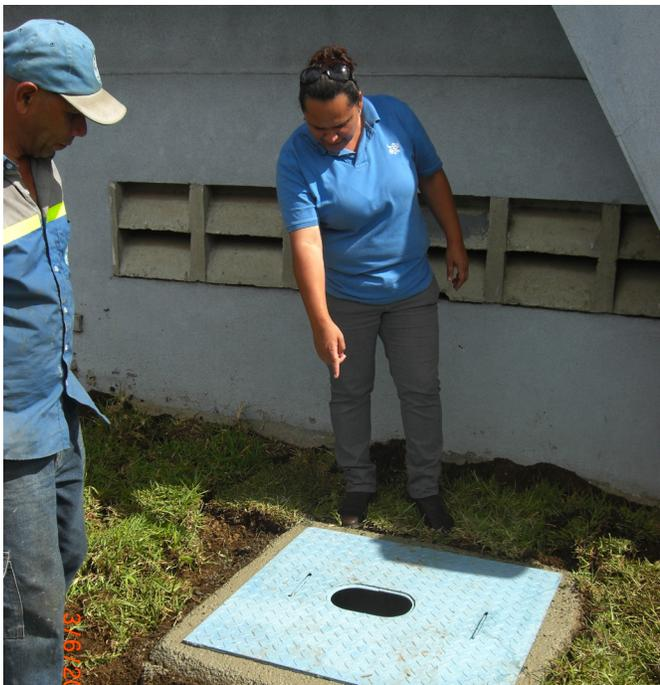
**Fotografía No 5:** Caja de protección del medidor principal instalado
